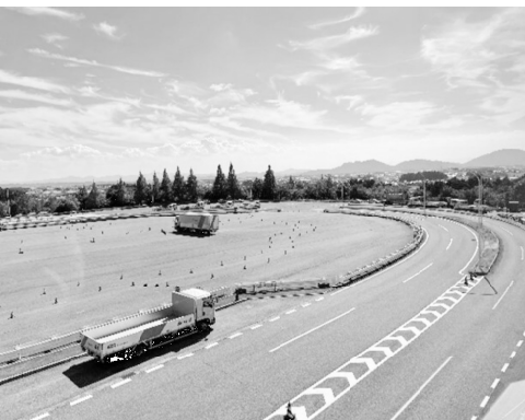
左奥がウエット路面施設
